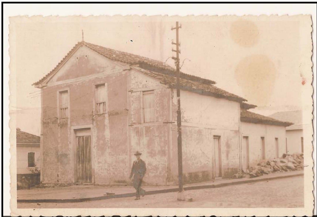
FIGURA 45: Frente e lateral direita da Igreja do Rosário. Data: 01/10/1956.
