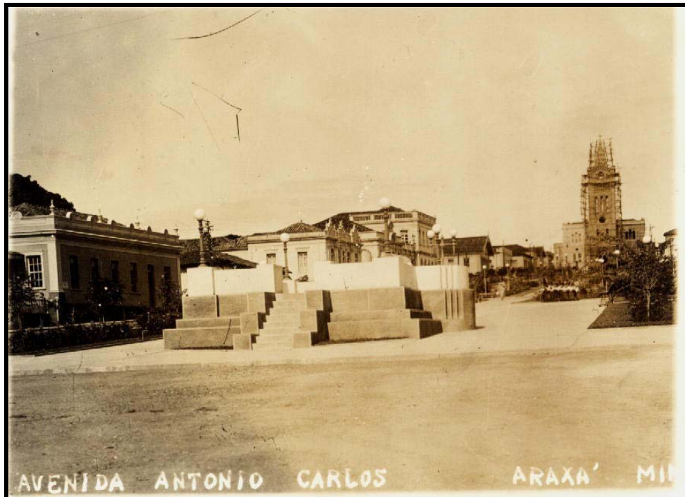
FIGURA 64: Avenida Antônio Carlos. Data: 1940/1942. Fonte: Arquivo FCCB/SAPP – Foto 00410.
