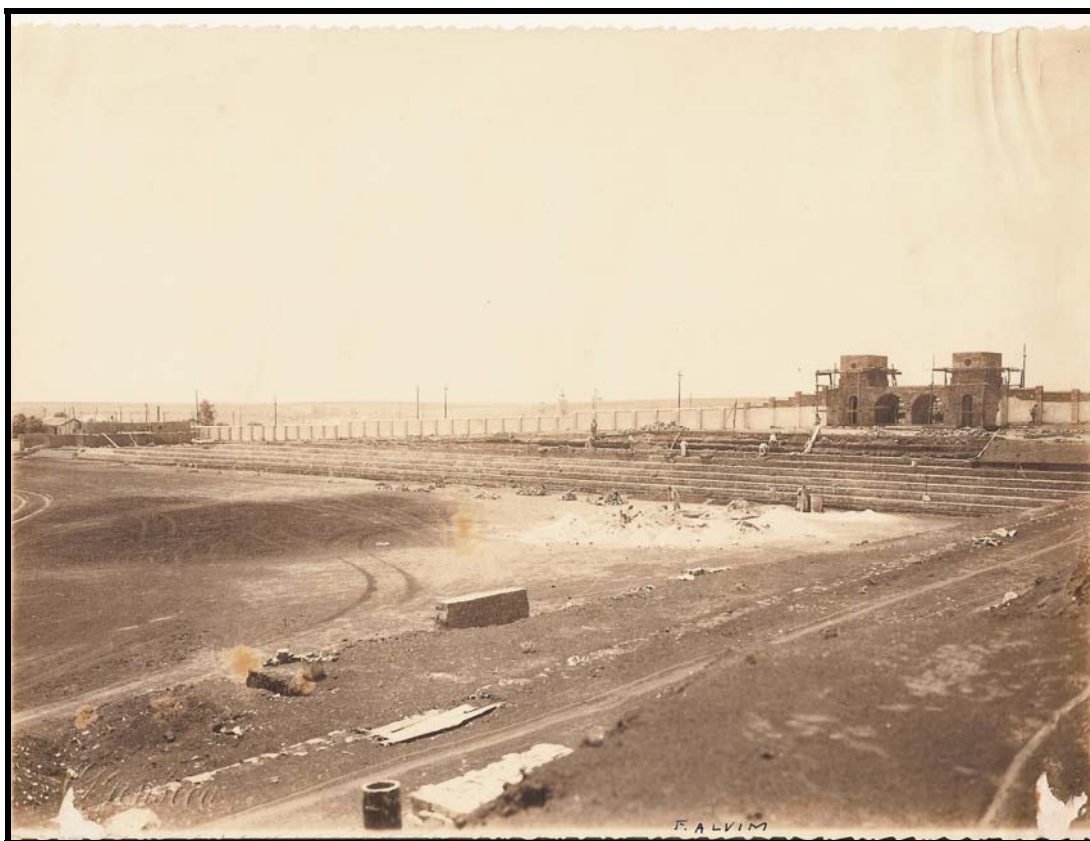
FIGURA 01: Construção do Estádio Municipal e Araxá Tênis Clube – A.T.C. Vista das arquibancadas e portaria central. Administração do Prefeito Fausto Alvim. Data: 1938/1940. Fonte: Arquivos da FCCB/SAPP – Foto 00012.
