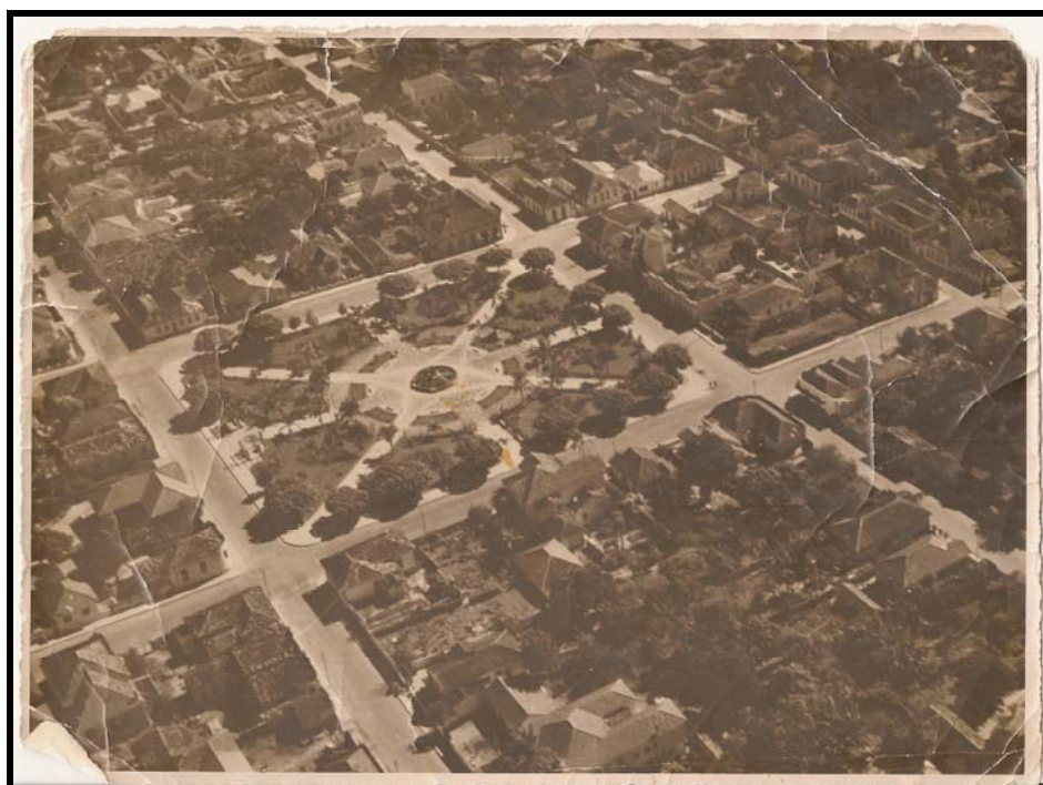
FIGURA 37: Vista aérea da região da Praça Governador Valadares. Data: 1950/1952. Fonte: Arquivo FCCB/SAPP – Foto 00216.
