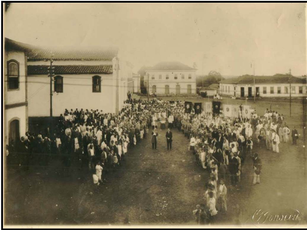
FIGURA 44: Crucifixo sendo conduzido por Eduardo Augusto Montandon, saindo do “Centro Catholico” para as novas instalações do Forum. Data: 04/07/1915.
