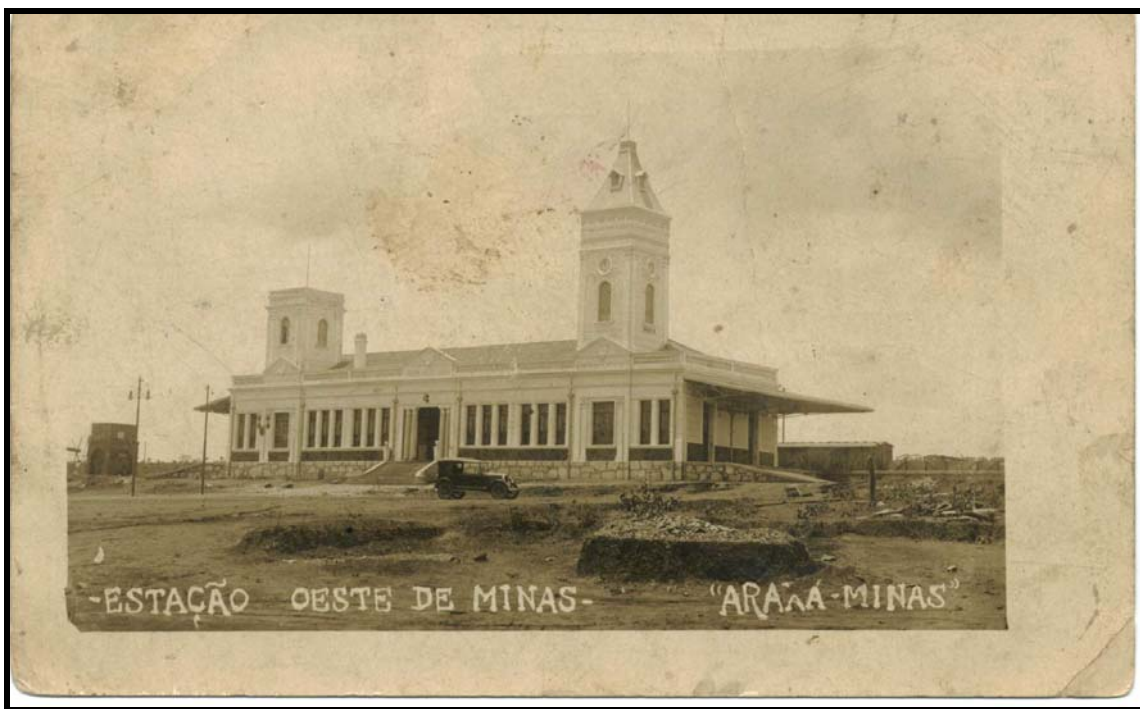
FIGURA 53: Antiga Estação da Estrada de Ferro Oeste de Minas, hoje sede da Fundação Cultural Calmon Barreto. Data: Década de 1930.
