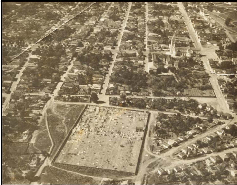
FIGURA 38: Vista aérea da parte central da cidade, vendo-se em primeiro plano o cemitério local. Data: 1950/1952.
