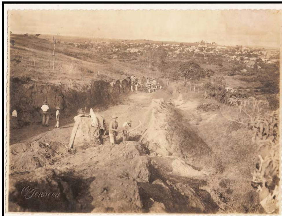
FIGURA 25: Trecho em construção da Rodovia Valadares, Araxá-Catiara, na subida da Santa Rita. Administração do Prefeito Fausto Alvim. Data: 1935/1939.
