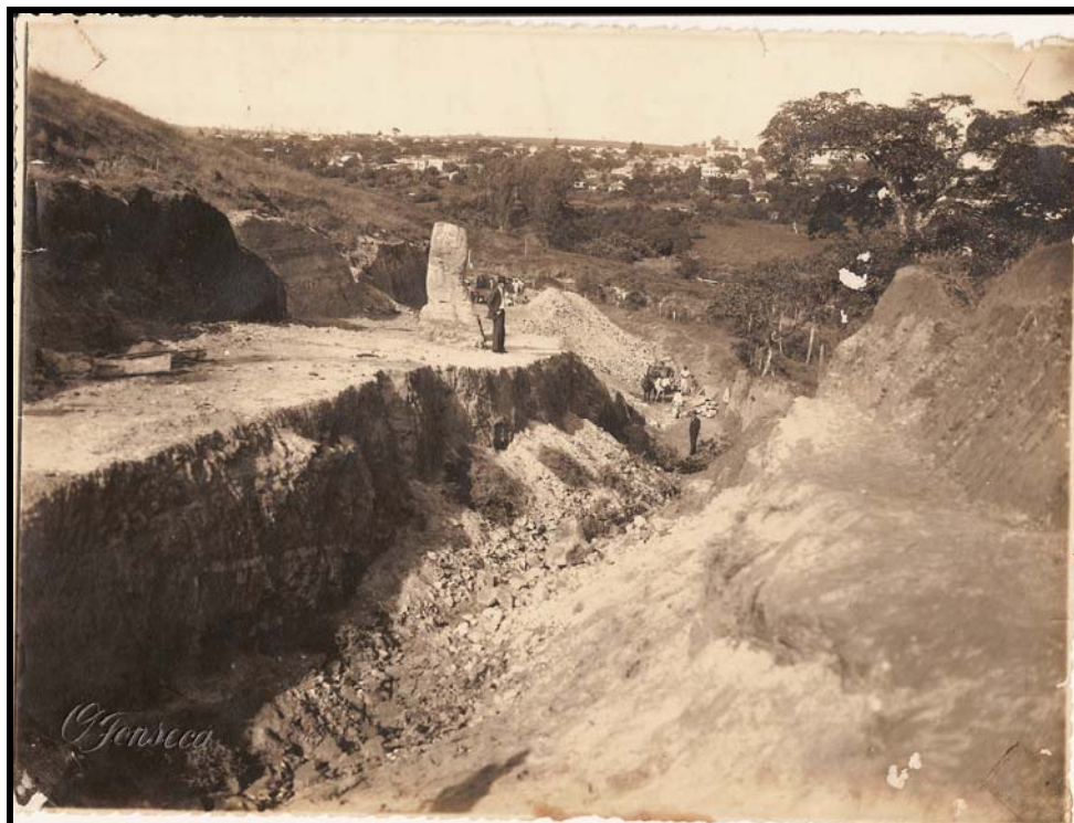
FIGURA 26: Trecho em construção da Rodovia Valadares, Araxá-Catiara, na subida da Santa Rita. Administração do Prefeito Fausto Alvim. Data: 1935/1939. Fonte: Arquivo FCCB/SAPP – Foto 00086.
