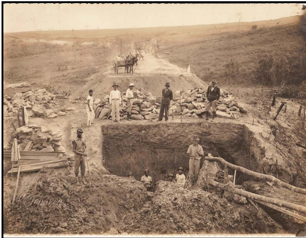
FIGURA 27: Obra de fundação do Pontilhão no Km 9 da Rodovia Valadares – Araxá/Catiara – Administração do Prefeito Fausto Alvim. Data: 1935/1939. Fonte: Arquivo FCCB/SAPP – Foto 00087.
