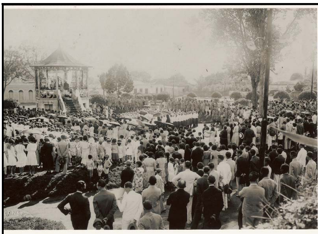
FIGURA 89: Coreto da Av. Antônio Carlos. S/data. Fonte: Arquivo FCCB/SAPP – Foto s/nº.
