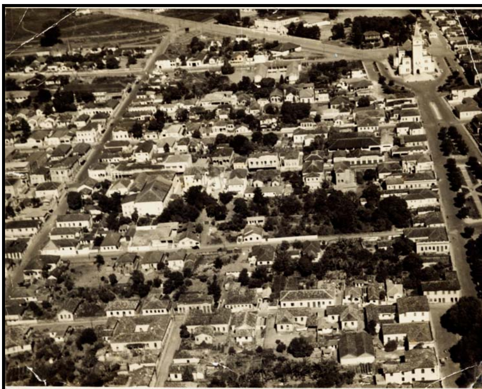
FIGURA 36: Vista aérea central da cidade de Araxá, vendo-se o colégio Dom Bosco, Igreja Matriz, Sobrado da Franca, Câmara Municipal e Casa Baroni. Data: 1950/1952 Fonte: Arquivo FCCB/SAPP – Foto 00215.
