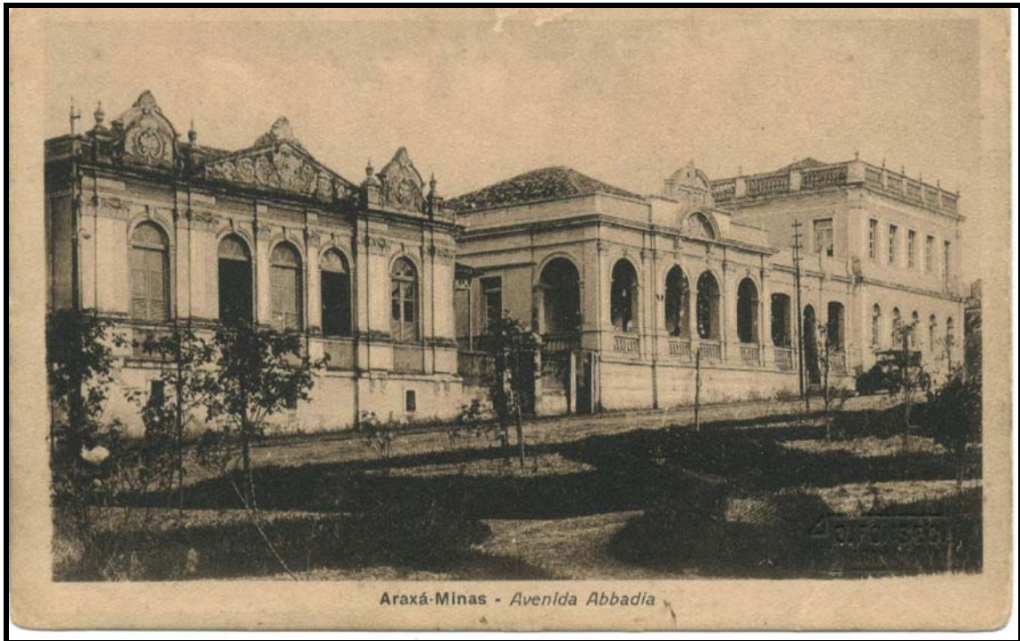
FIGURA 59: Avenida Abbadia, hoje, Av. Antônio Carlos. Data: 1928. Fonte: Arquivo FCCB/SAPP – Foto 00400.
