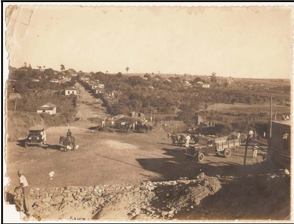
FIGURA 11: Trecho da construção da Rodovia Valadares, Araxá-Catiara, na subida da Santa Rita, próximo do Banheiro Público, no final da Rua Alexandre Gondim. Obra realizada no governo do Prefeito Fausto Alvim. Data: 1930/1940.
