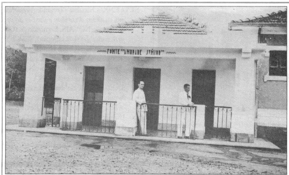
Prédio da antiga "Fonte Andrade Júnior", inaugurado em 1932. A atual fonte, construída no mesmo lugar, foi projetada por Francisco Bologna e concluída em 1947. Preservou a denominação anterior e é uma homenagem ao cientista responsável pelo projeto de captação das águas sulfurosa e radioativa do Barreiro. Fotografia da década de 30. (SPH-00353). (Doação de Manoel Lopes da Silva).
