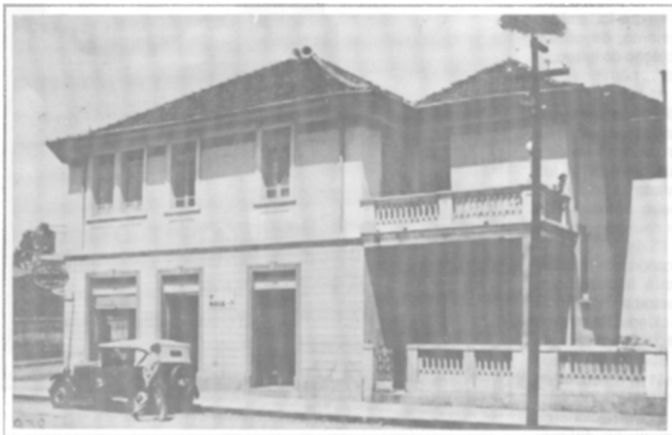
Residência e loja de Domingos Zema na antiga Av. 3 de outubro. No telhado, veem-se os alto falantes da rádio que ele pretendia instalar. Acervo Julieta Zema.
